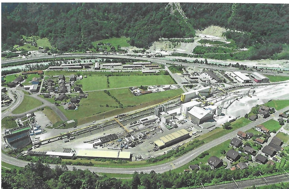
Foto: un cantiere del Gran San Gottardo
